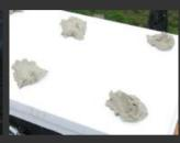
Den Kleber - je nach Untergrundbeschaffenheitentweder (bei glattem Untergrund) vollflächig mit der Zahnkelle oder (bei starken Unebenheiten) im Wulst-Punkt-Klebeverfahren auf der Dämmstoffplattenrückseite aufbringen. Die Platte am Sockelprofil ansetzen und fest an die Wand pressen.
